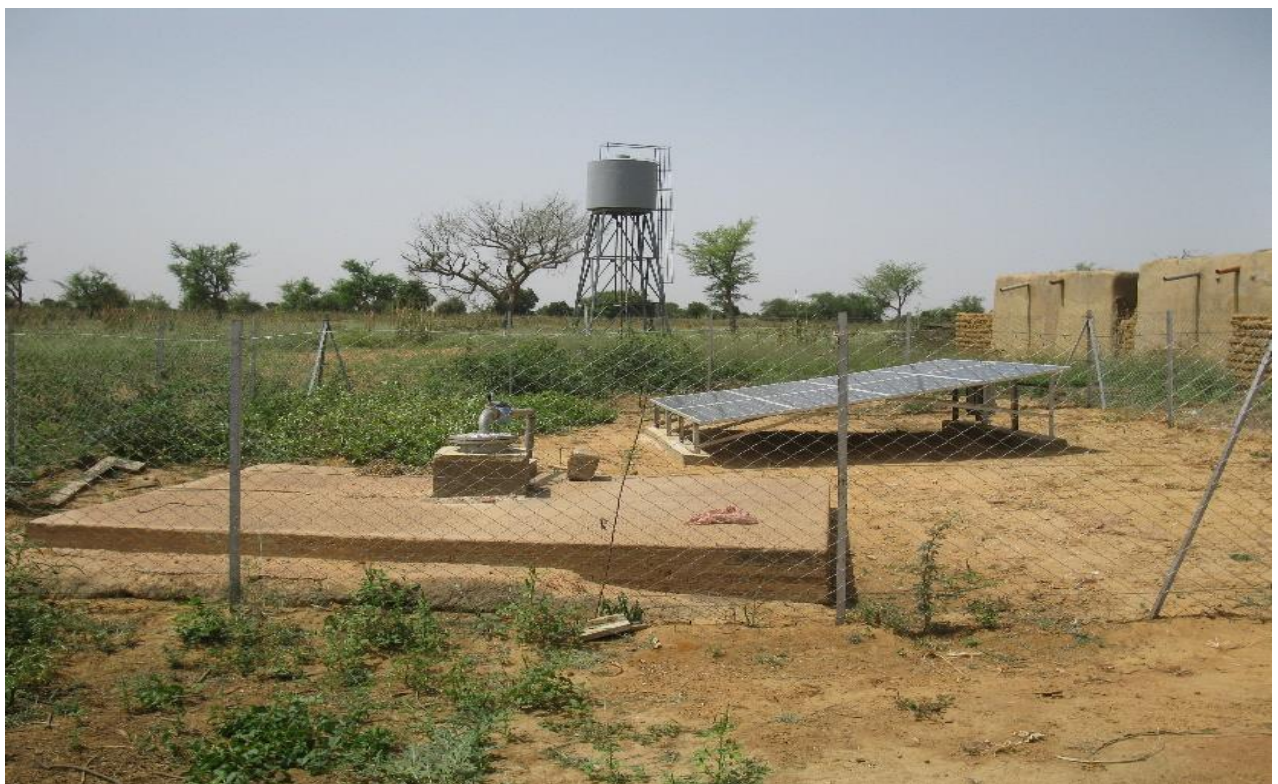
Equipement attendu : un forage, une pompe à énergie solaire, un château, un champ de cellule photo voltaïque et des bornes fontaines.
